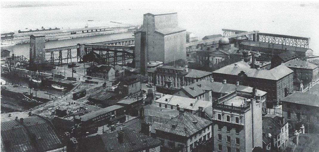
On voit ici l'élévateur à grain de la Great Northern Railway company détruit par un incendie en 1909. C'est sur ce site qu'a été construit l'édifice administratif du Port. On aperçoit également les deux convoyeurs à angle droit qui dirigeaient le grain au-dessus du Quai de Pointe à Carcy, pour le chargement du grain destiné à l'Europe.
